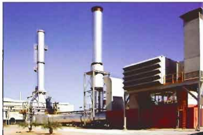
Turbina de gas y caldera de recuperación de la planta de cogeneración
