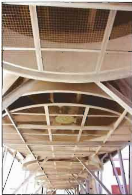
El aerocondensador permite reducir casi un 100 % el consumo de agua
