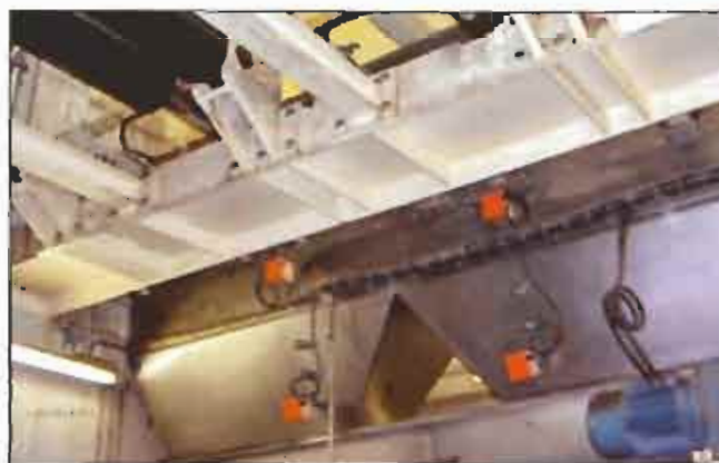
Silo múltiple con sistema de piso móvil independiente
