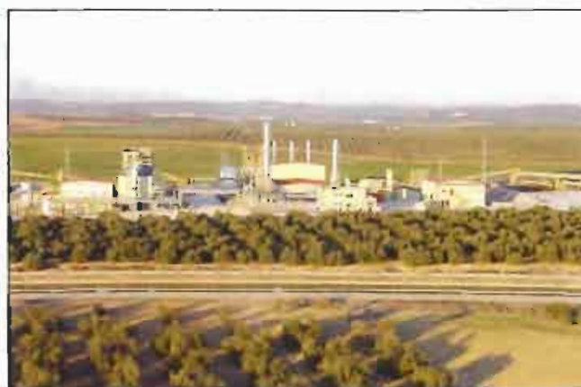
Vista general de la Planta de Puente Genil
